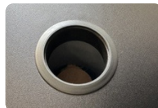
Predisposizione per sprinkler antincendio.
