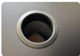
Predisposizione per sprinkler antincendio.
