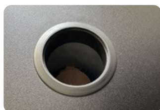
Predisposizione per sprinkler antincendio.
