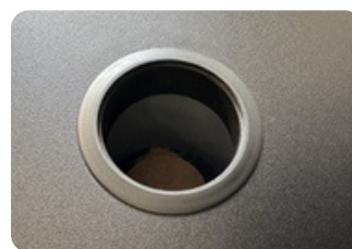
Predisposizione per sprinkler antincendio.
